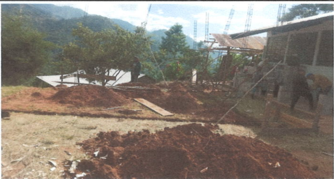
Foto 3: Levantamiento de columnas
