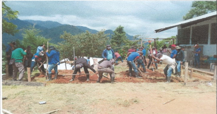
Foto 2: Inicio de cimiento
