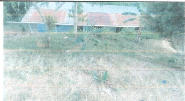
Foto 4: Una infraestructura poco segura y en malas condiciones pone en riesgo la integridad de la niñez en las aulas de clases.
