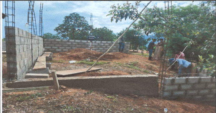
Foto 4: Levantamiento de paredes y pequeño muro de contención
