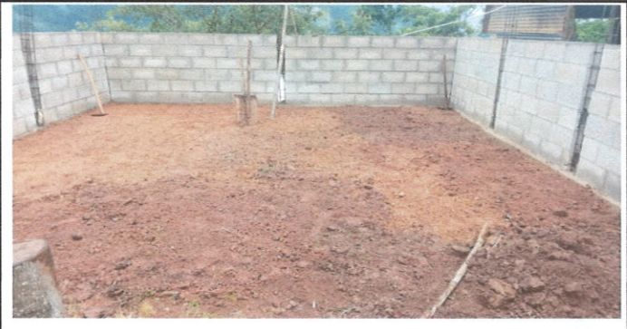
Foto 6: Nivelación de piso de tierra
