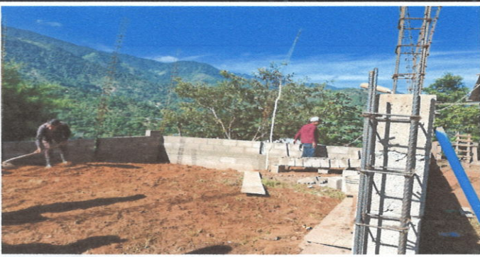
Foto 5: Fundición de columnas
